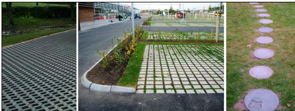
Figur 9. Ytor med hålsten av betong samt gångstig med gräs och gångplattor
