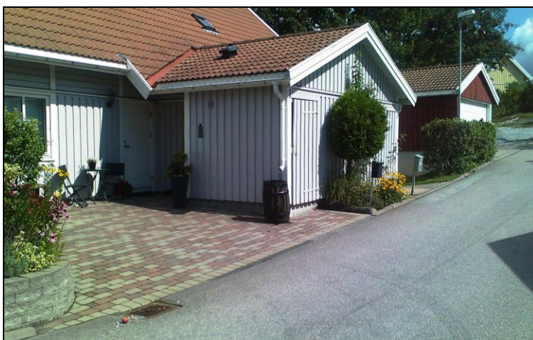
Figur 16. Regnvattentunna för magasinering av dagvatten
