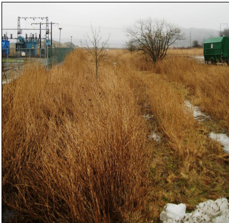
Figur 3. Dike utmed fördelningsstationen i områdets norra del
