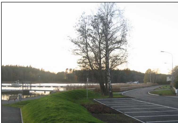
Figur 13. Exempel på högvattenskydd i Nora Strand, Danderyd, med jordvall som övergår i träbeklädd spont
